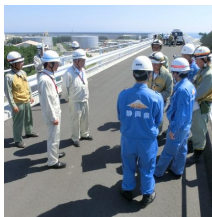
発電所敷地東側西側盛土の嵩上げ 点検の様子
