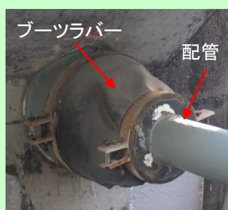
配管貫通部の例 (ブーツラバー)
