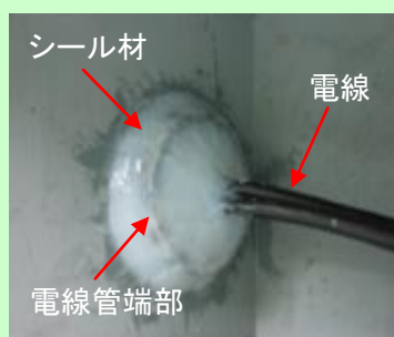
電線管貫通部の例 (シール材)
