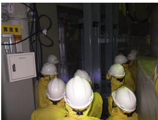
原子炉建屋ベント設備 点検の様子
