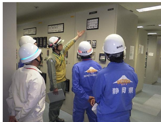
原子炉建屋への水素濃度計設備 点検の様子
