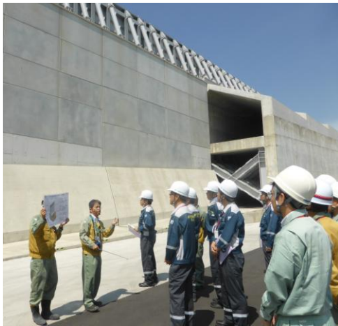
現地視察の様子(防波壁)
