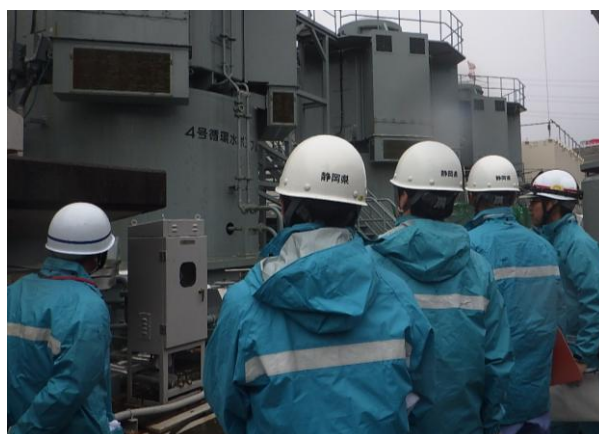
循環水ポンプ周辺の溢水防止対策 点検の様子
