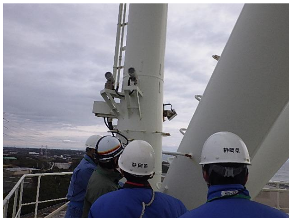
森林火災感知(監視)カメラの設置工事 点検の様子
