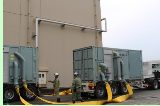
代替熱交換器車両設置の様子
