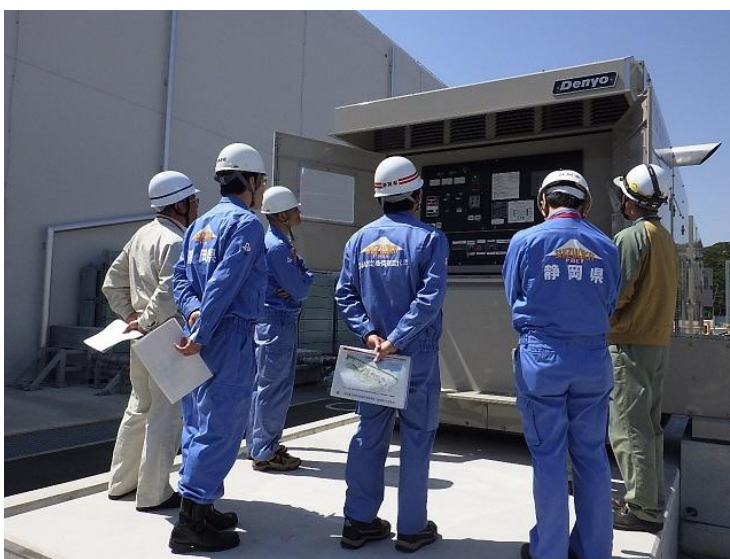
緊急時対策所の機能確保工事 点検の様子
