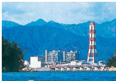
尾鷲三田火力発電所
