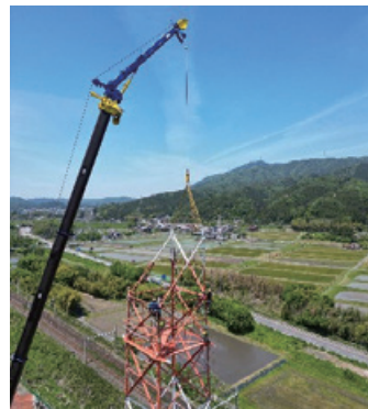
鉄塔の建替工事の様子
