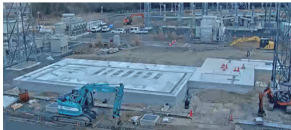
東栄変電所変圧器増強工事（基礎工事）
