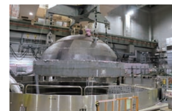
原子炉圧力容器上蓋取り外しの様子
