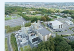
美濃加茂バイオマス発電所
