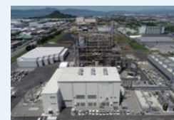
八代バイオマス発電所
