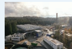
Eavor Technologies より提供
