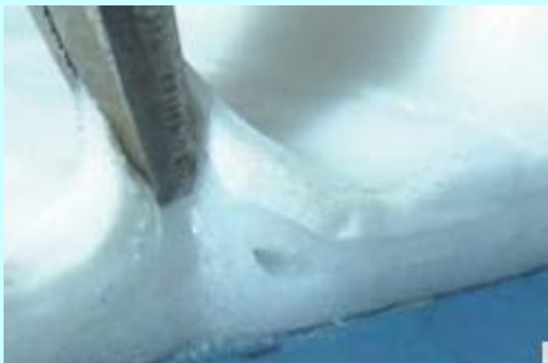
漏水からの保護
