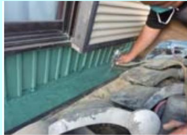
構造物の補修
