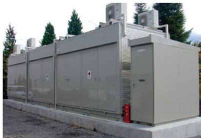
「高圧キャパシタ式瞬低補償装置」
