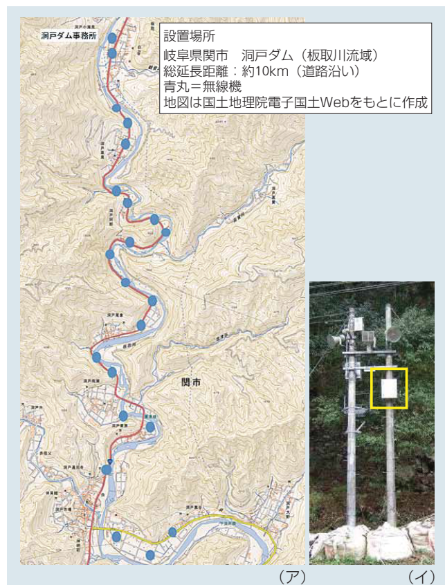
第1図 無線機の設置場所と取付状況
