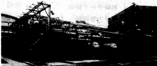
第1図 冷熱発電所全景
