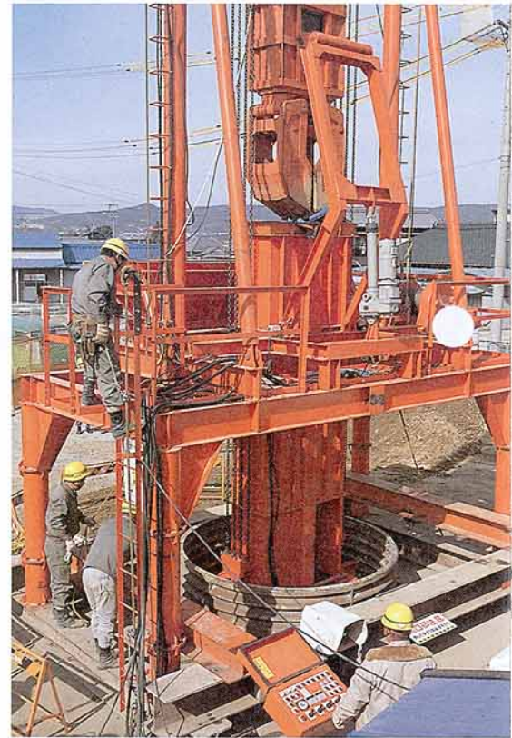
第2図 掘削試験
