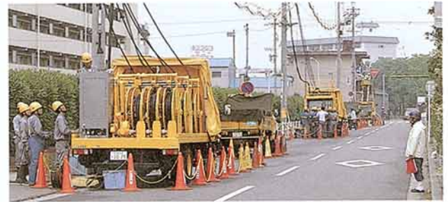
第1図 開発車による無停電作業
