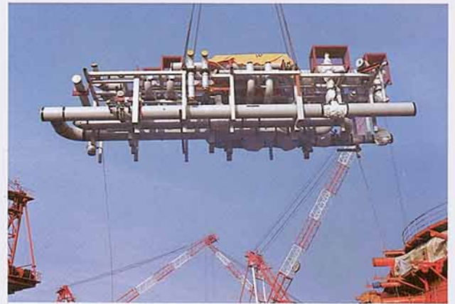
第1図 一体化製品搬入状況
