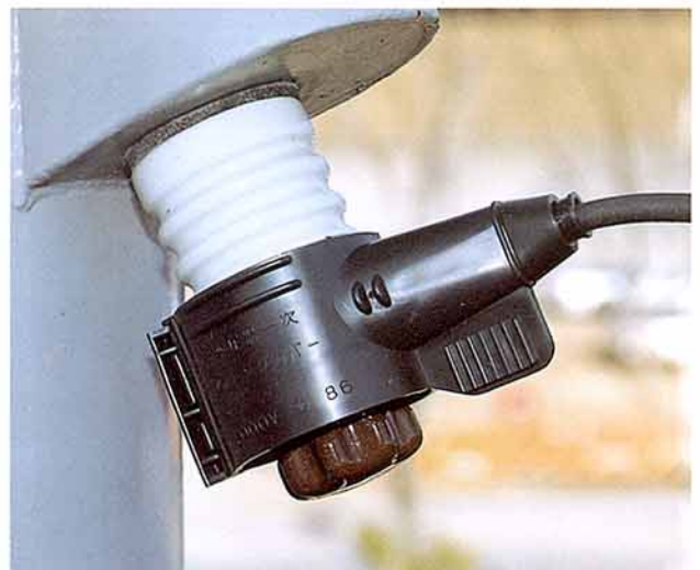
第3図 変圧器一次ブッシングカバー取付状況
