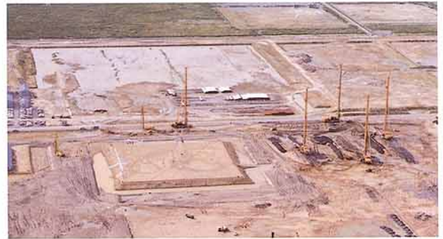
第1図 試験盛土工事状況 (四日市 LNG 基地)
