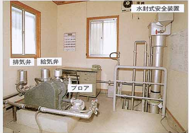
第4図 ダムの操作機構
