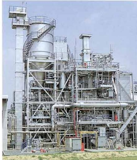
石炭バンカ (左) ボイラ (中) 脱硝装置 (右)
