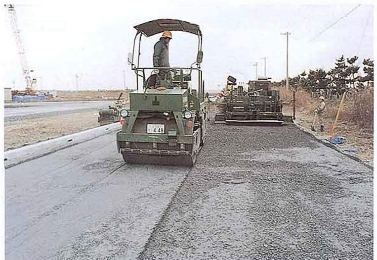
第2図 路盤の施工
