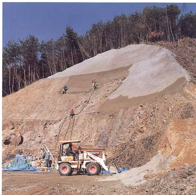
第1図 切取の一例(新上麻生発電所 水槽)
