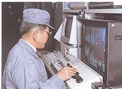
監視・制御を行う親局(監視箇所) テレビカメラの映像を見ながら、ジョイスティックでロボットを操作
