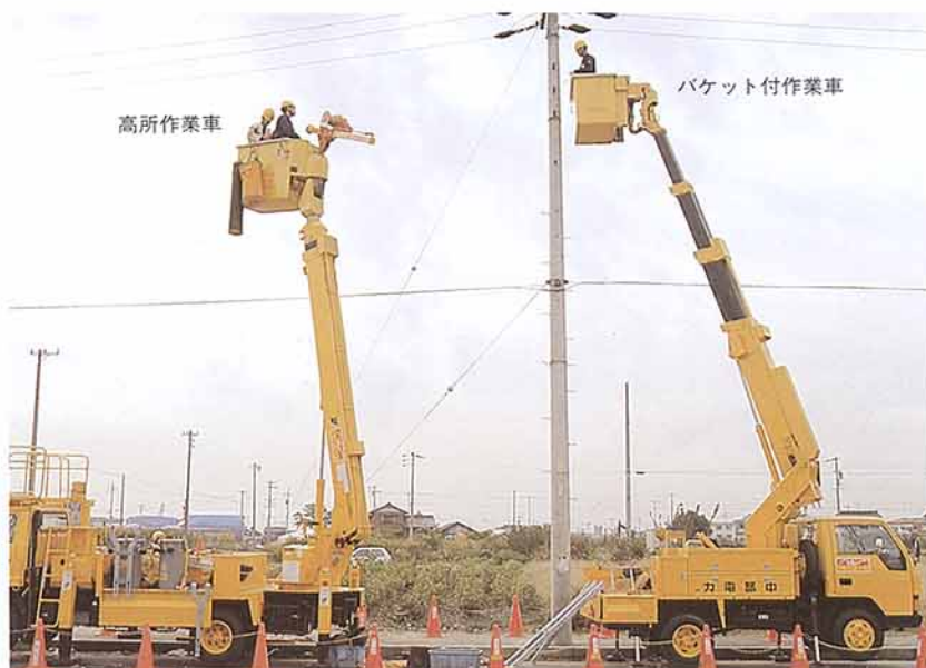
第2図 配電設備新設作業
