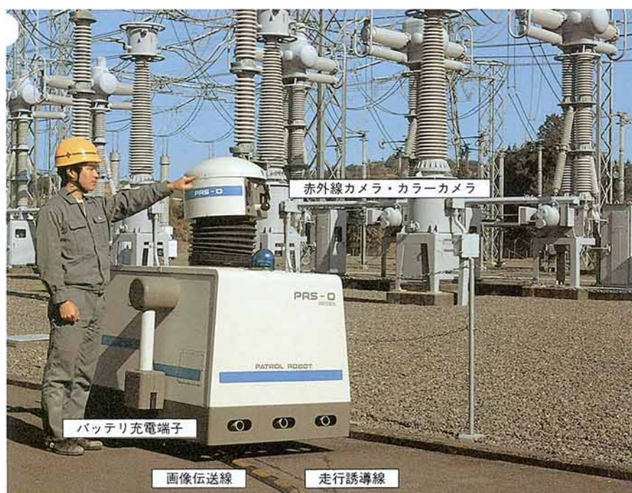
変電所構内を巡視するロボット
