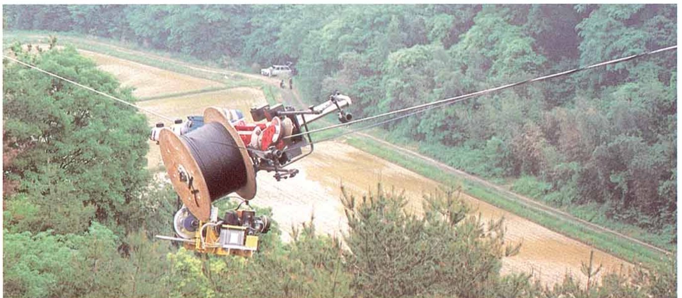
第3図 ケーブルの施工
