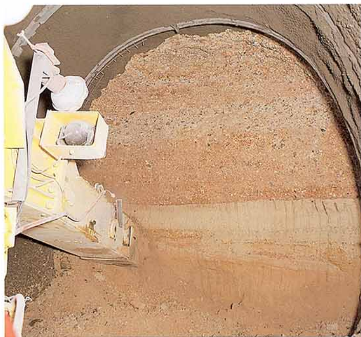
第2図 砂れき地盤の掘削
