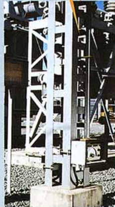
■断路器不完全投入と局部過熱の検出 不完全投入時の機械的な位置検出と局部過熱時の形状記憶合金 (60°Cで変形) による動作によって、中間電極と充電部間に電位差が生じ、ギャップ間で放電する。放電による電磁波を検出
