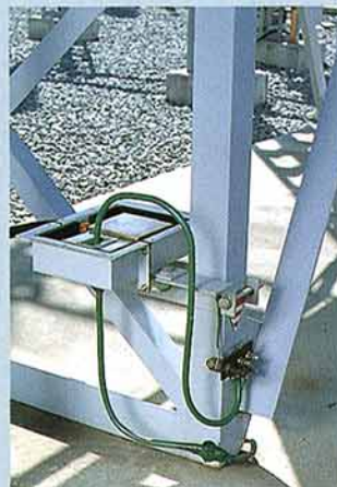
■接地線電流センサ 機器の絶縁劣化時に接地線に流れる高周波電流を高周波CTで検出し、455kHz成分を同調増幅
