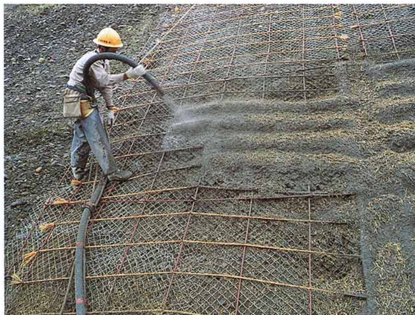
第1図 緑化コンクリートの施工
