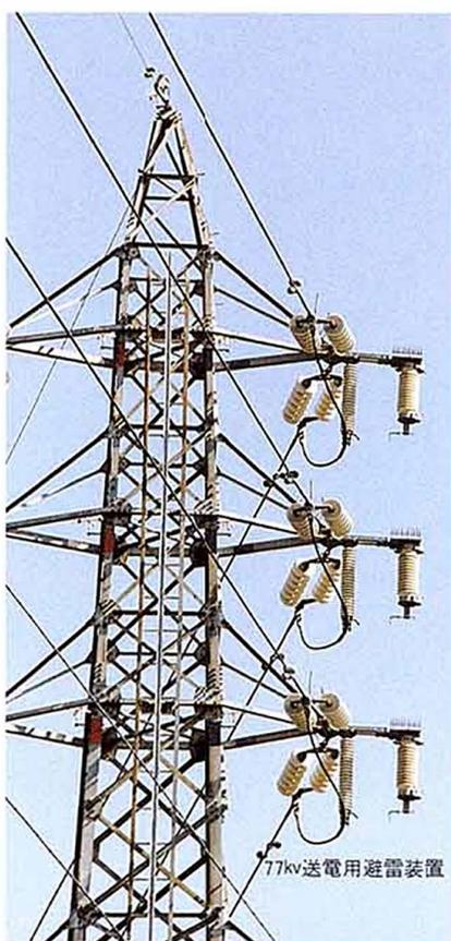
77kV送電用避雷装置
