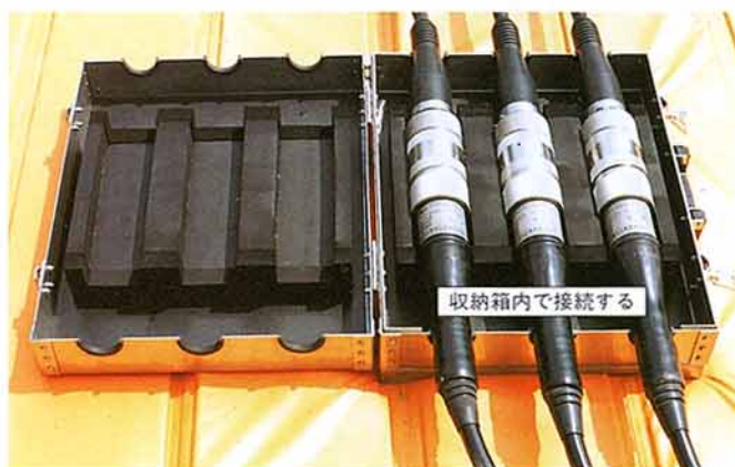
第5図 中間接続筒収納箱 (蓋を開けた状態)
