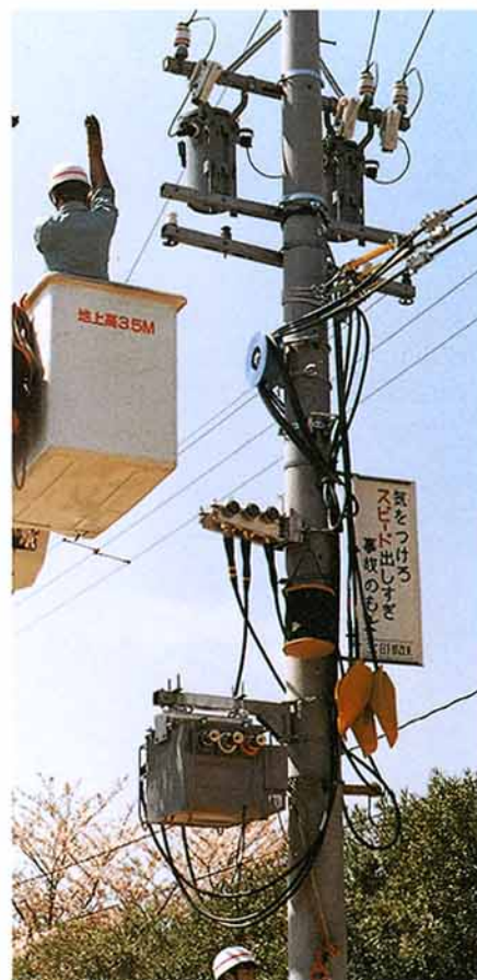
機材布設状況
