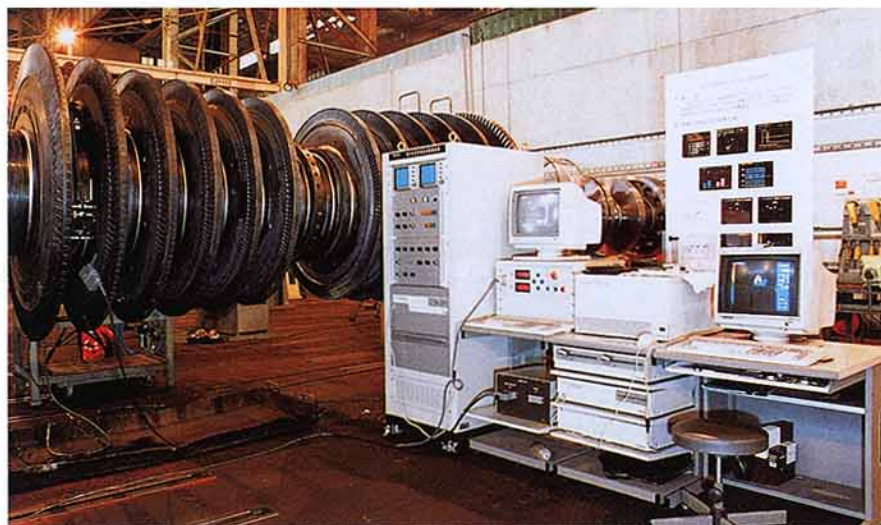
第3図 実機での探傷状況
