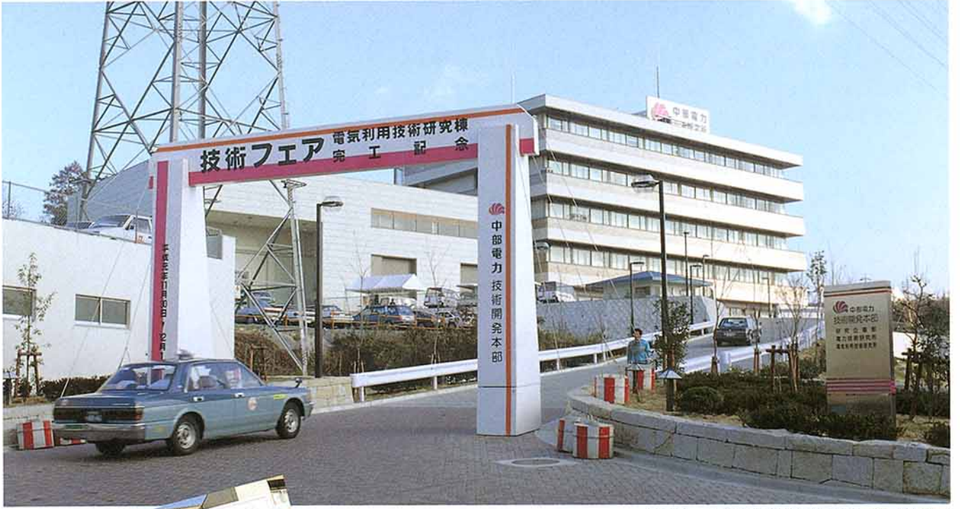
技術フェア入口と完工した電気利用技術研究棟
