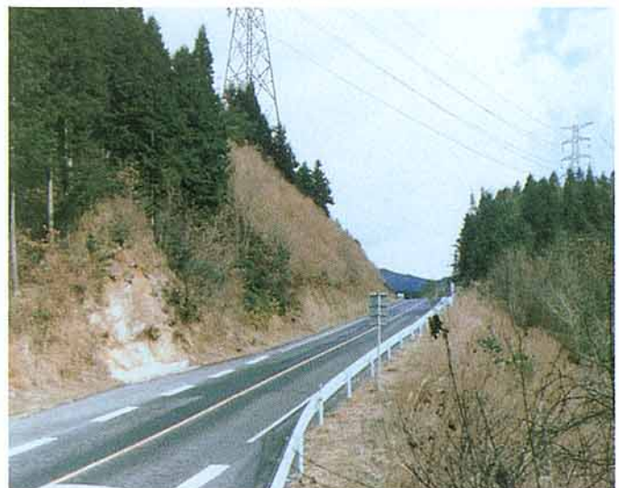
第3図 景観シミュレーション画像合成 (画像中の送電線鉄塔はCGにより作成したもの)
