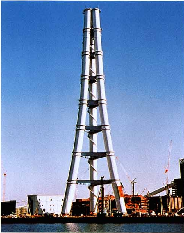
第1図 碧南火力発電所煙突
