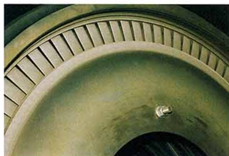
第2図 蒸気タービン中圧初段ノズル溶射外観
