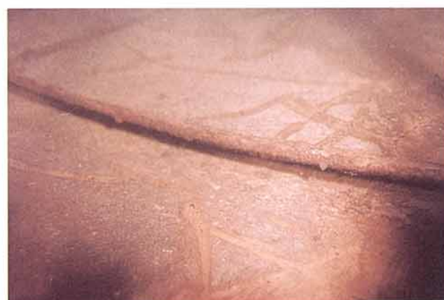
第2図 水圧鉄管壁面状況
