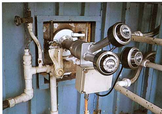
第1図 送受波器の取付状況
