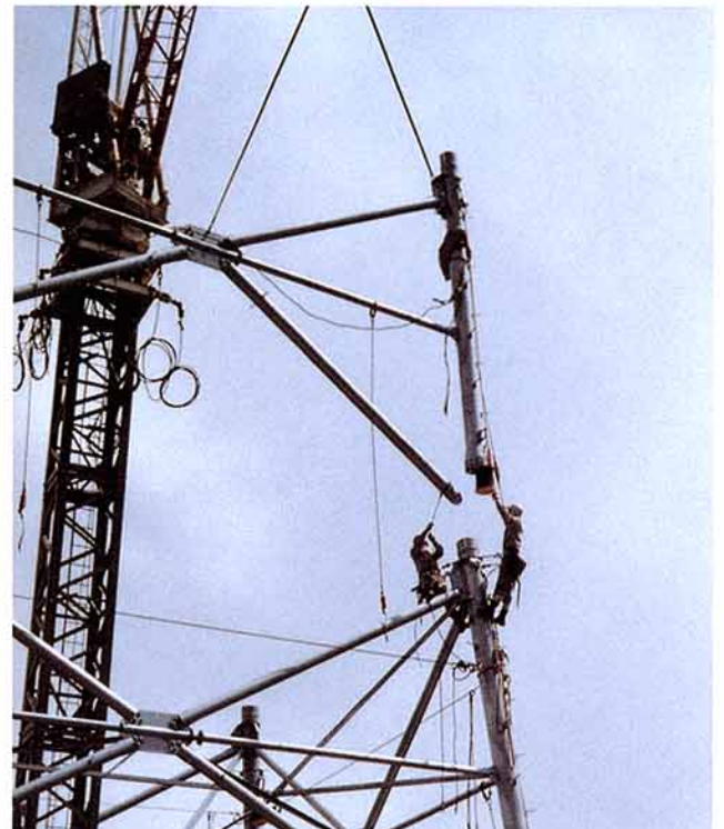
第2図 タップ型ボルト方式鋼管鉄塔の組立風景
