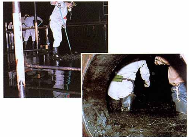
第1図 人力による固形化油分の除去
