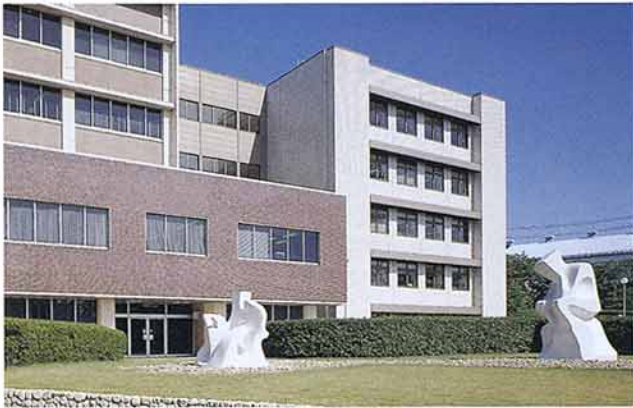
56.12.1 本館増築完工
