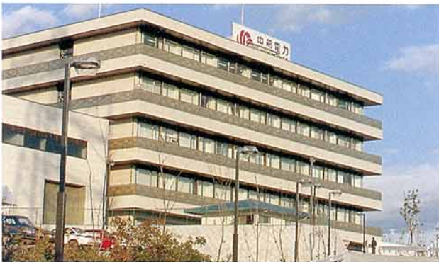
完成した電気利用持術研究棟
