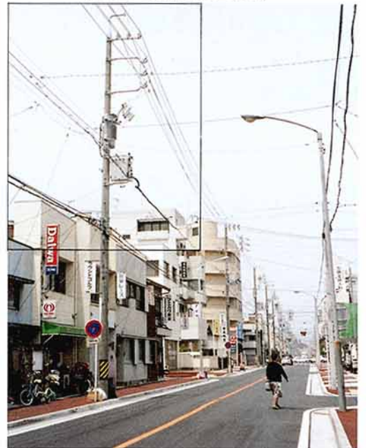
第4図 新装柱(工事後)
