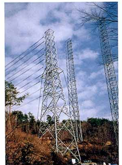
第3図 大型圧延山形鋼鉄塔の耐力試験状況
