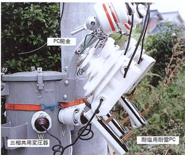
第1図 耐塩用耐雷PC取付状況
