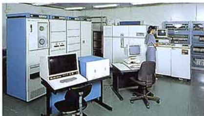
コンピュータ室
